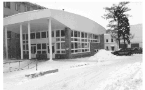
Новый вход в корпус «Б» (введен в эксплуатацию в 2003 г.)
